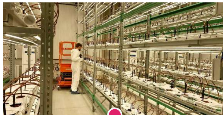
Многоярусные вертикальные конструкции
