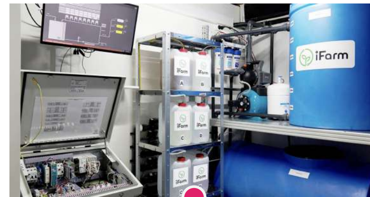
Управляющий блок с подключением к облачному серверу
