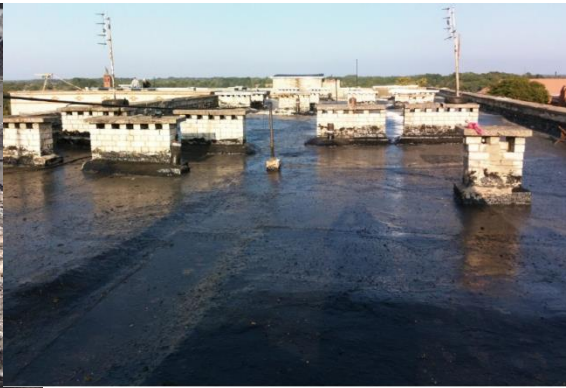
Нанесение Вир-Пласта
