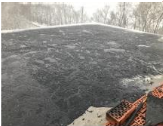
Нанесение Вир-Пласта
