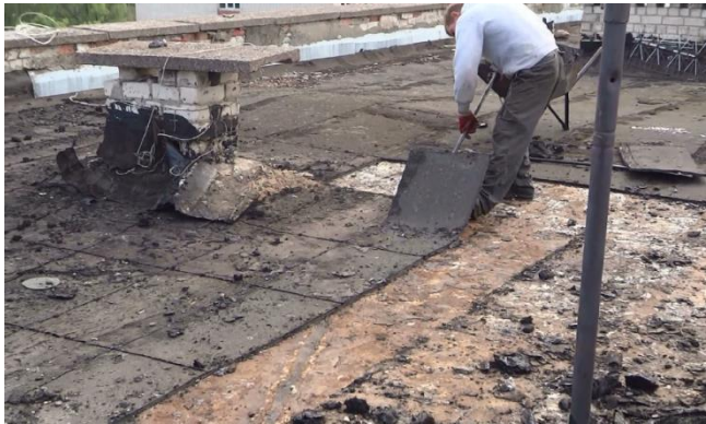
Снятие старой кровли
