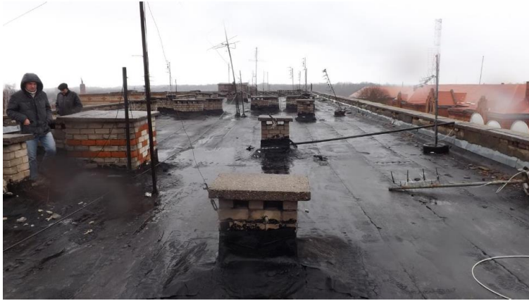
Снятие старой кровли
